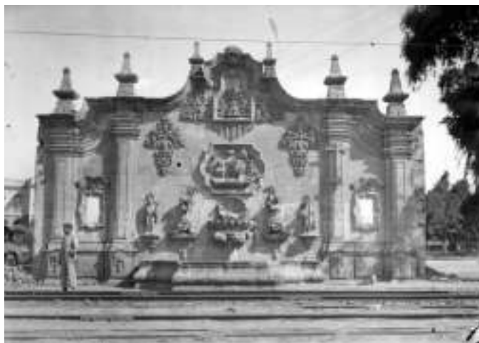
Fotografía de la fuente a principios de siglo xx. Tomada de Comisión Nacional del Agua https://www.gob.mx/conagua/es/articulos/belen-la-fuente-mas-antigua-de-la-cdmx?idiom=es
