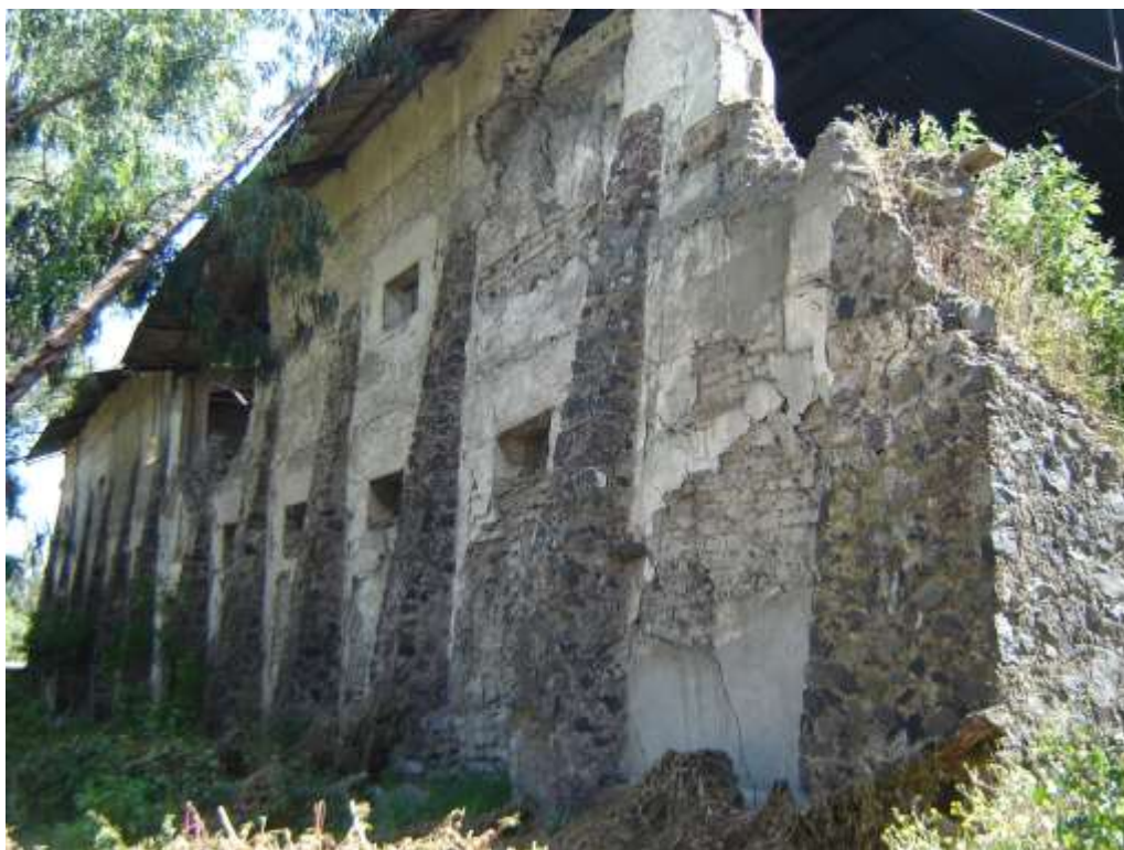
Detalle de la fachada lateral de la troje, 2009.
