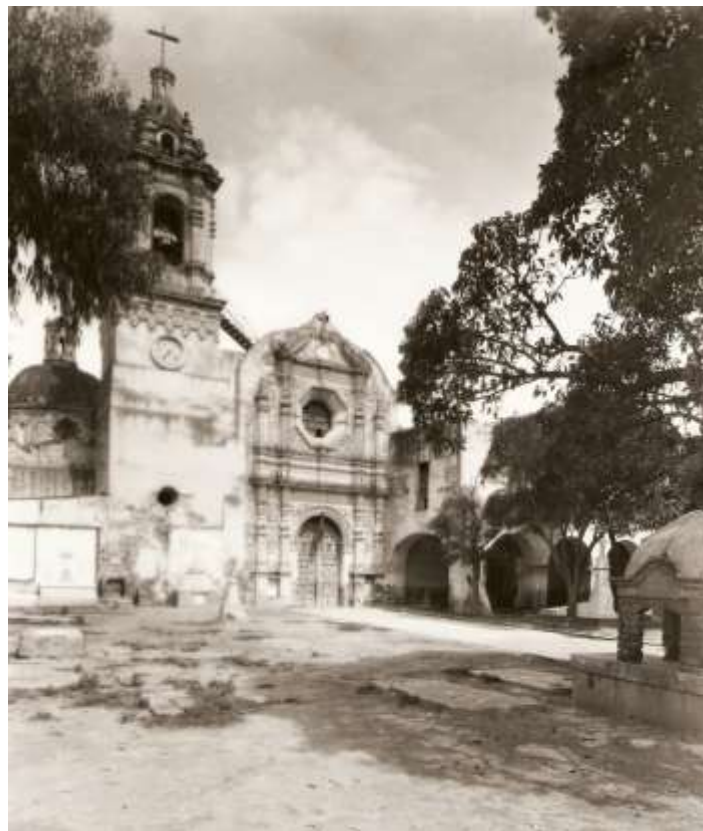
Fachada principal de San Matías, s/f.
